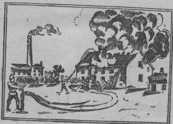
Водопровод во время пожара.
